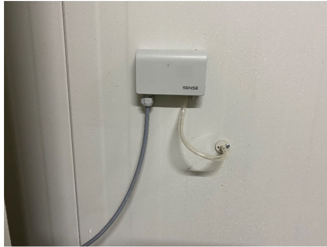
Şekil 5. Basınç fark sensörü
